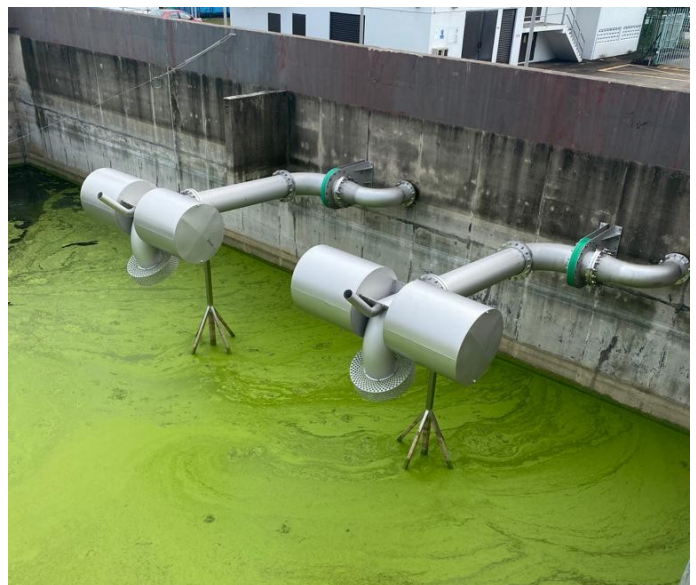
Sonderform als Klarwasserabzug mit Siebkorb
